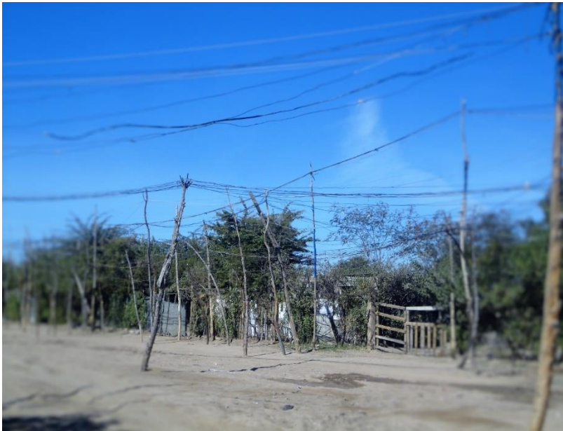
Fotografía 2. Fugas de agua potable y diablitos de luz en invasión.
