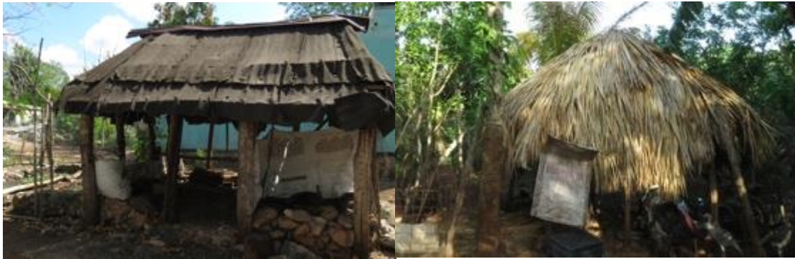
Figura 17. Gallinero en Yaxunah. A) Gallinero con techo de lámina de cartón y piso de cemento. B) Gallinero con techo de huano que es parte de un apoyo del programa de la UADY.
