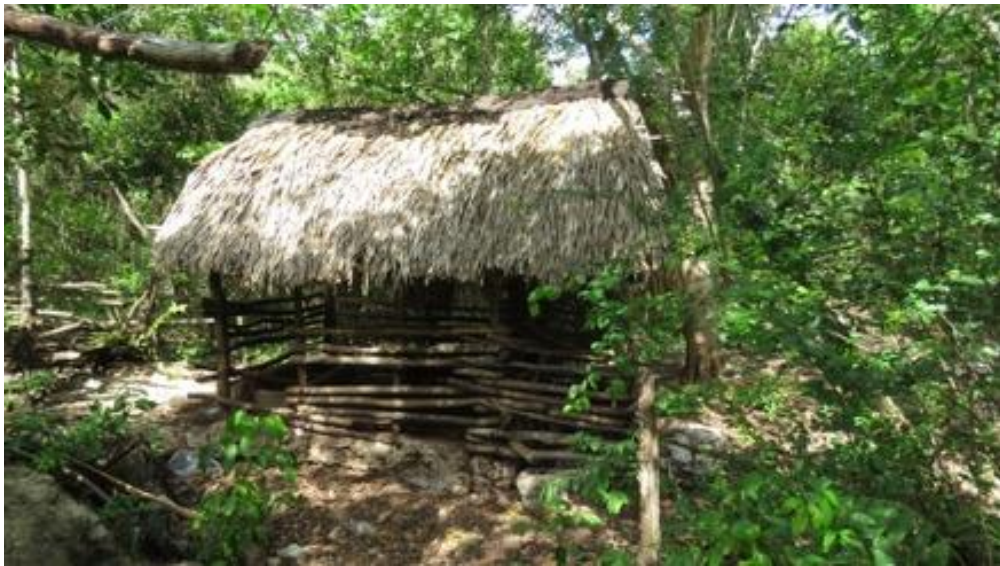
Figura 16. Chiquero de bajareque, con techo de huano y piso de cemento en Yaxunah. Fuente: trabajo de campo (2018-2019)
