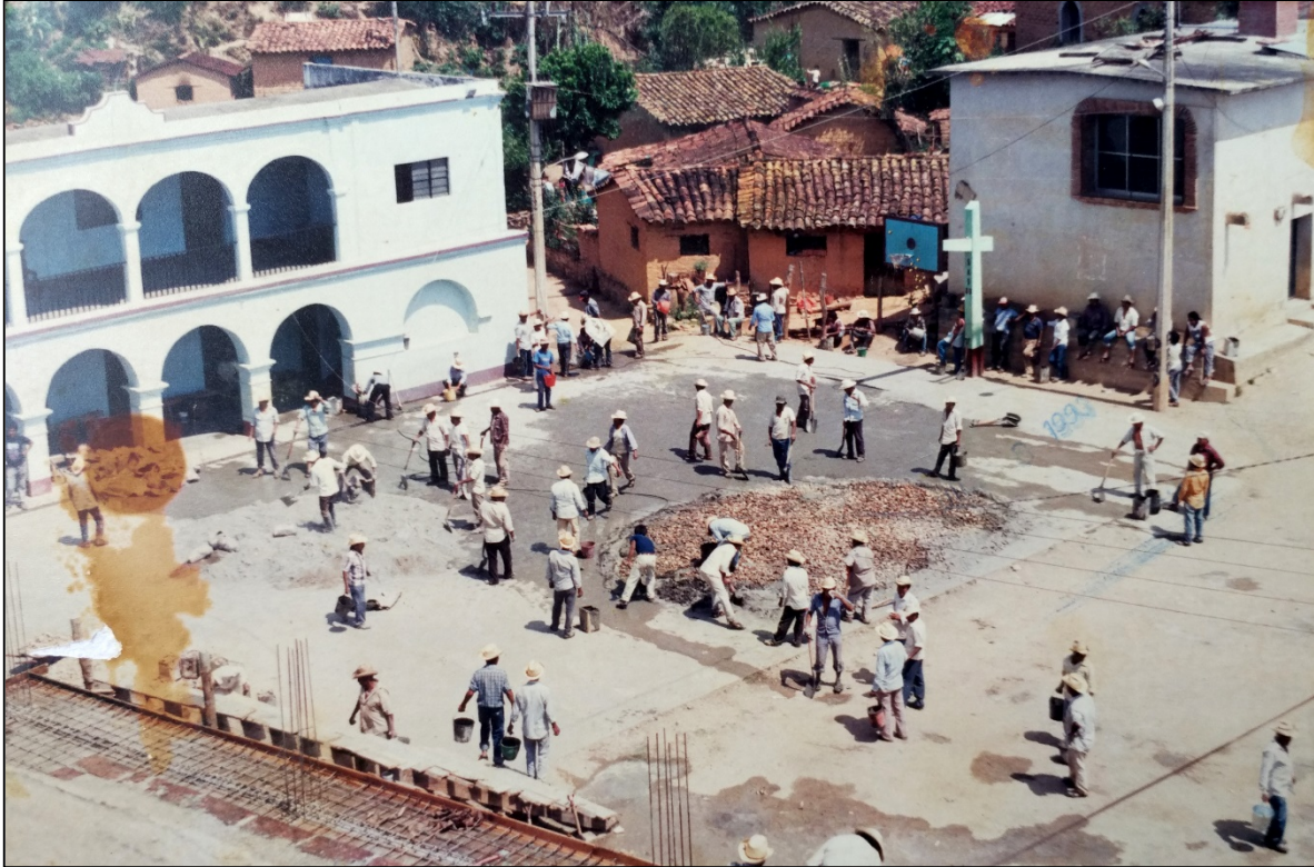
Foto 5. Tequio de construcción en Solaga en la década de los 80s.
