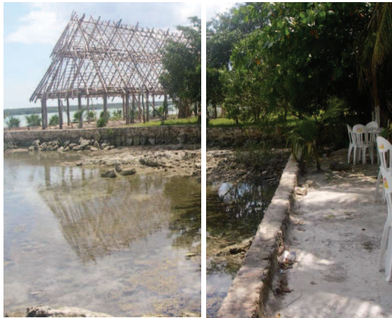
Figura 18. A la derecha, predio que invadió zona federal, cuyo propietario fue multado por la Tesorería Municipal. A la izquierda al fondo, construcción en zona federal que, a decir del entrevistado, no tiene conocimiento de que el responsable haya sido multado.
