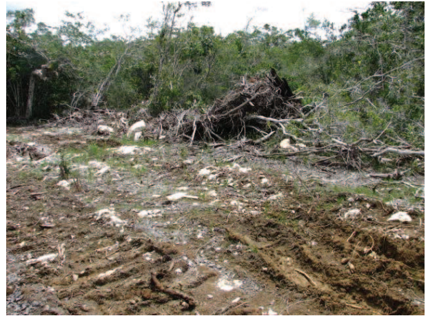
Figura 8. Huellas de la maquinaria utilizada en la apertura del nuevo camino.
