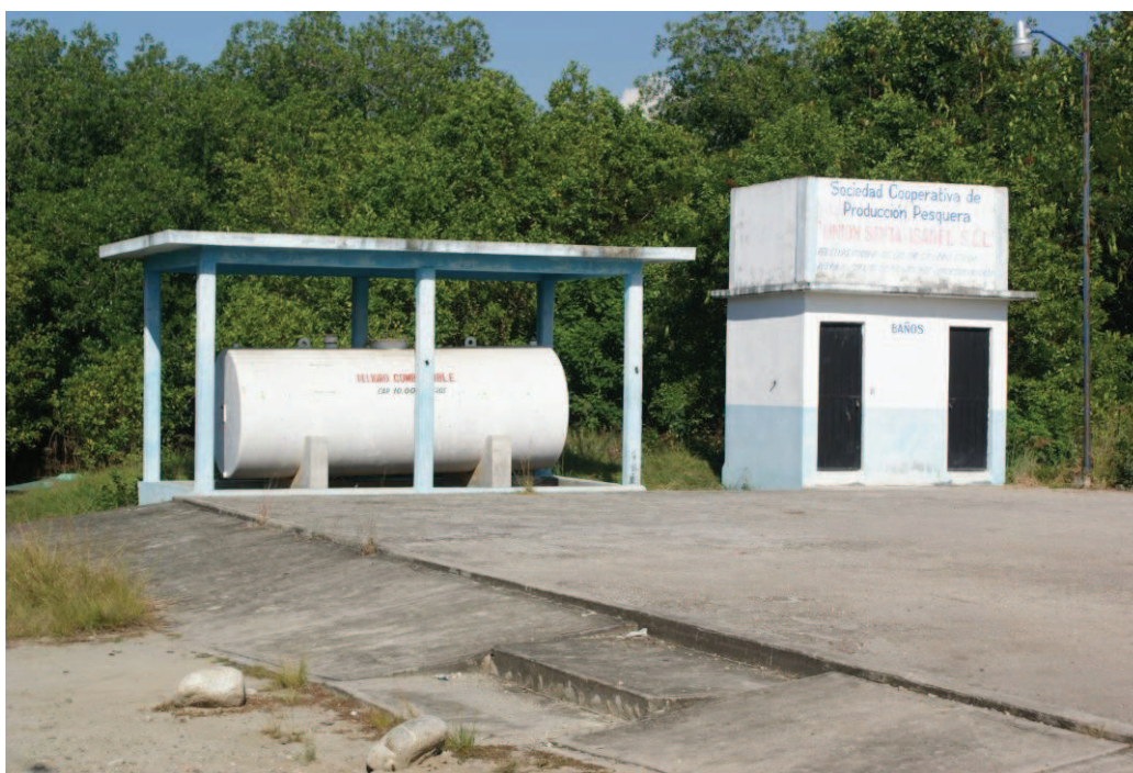
Figura 29: Infraestructura abandonada (depósito de combustible)
