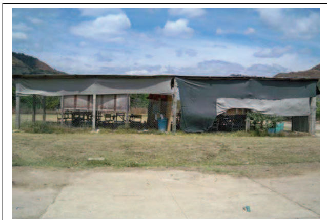
Figura 32. Escuela primaria San José Montenegro.
