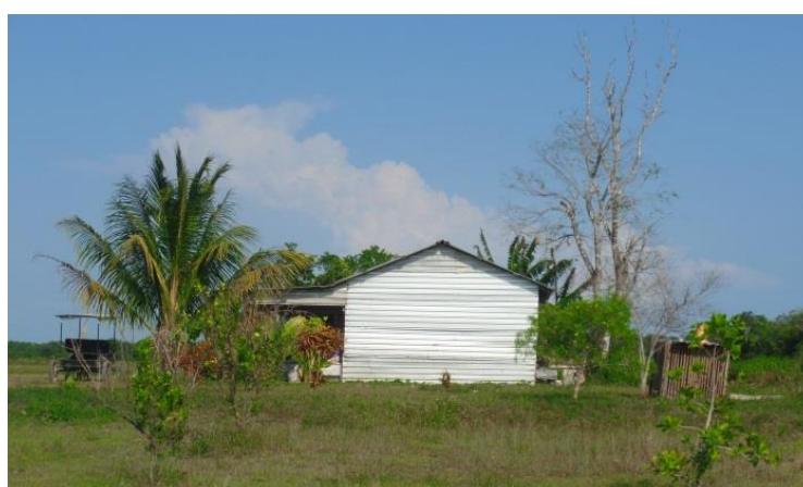
Figura 8: Casa construida con lámina.
