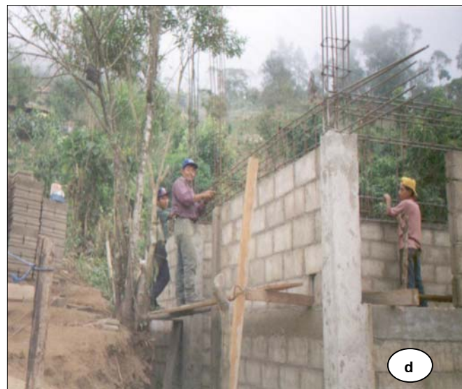
Vivienda en construcción, barrio Pavencul, 2000
