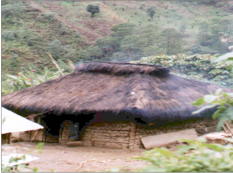
Vivienda tradicional, con techo de pajón, paredes de bajareque y piso de tierra. Barrio Vega de los Molinos, Pavencul, 2000
